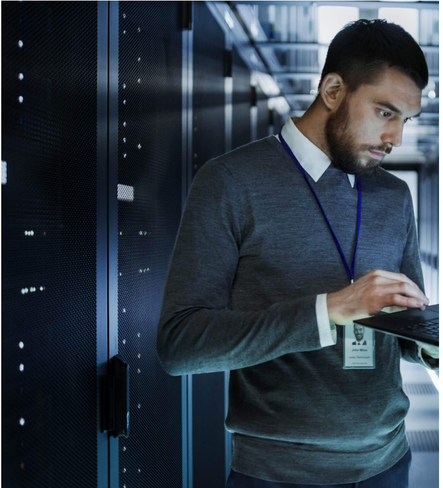
サーバールーム
