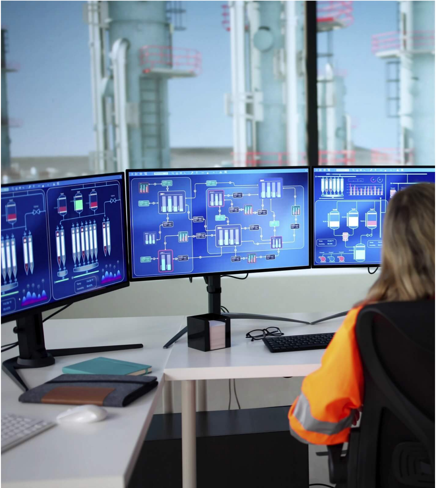
石油精製施設
